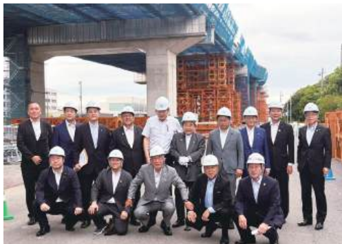
▲大変な難工事の現場にて。埋立地での工事 で杭は50m以上も打ち込みます
